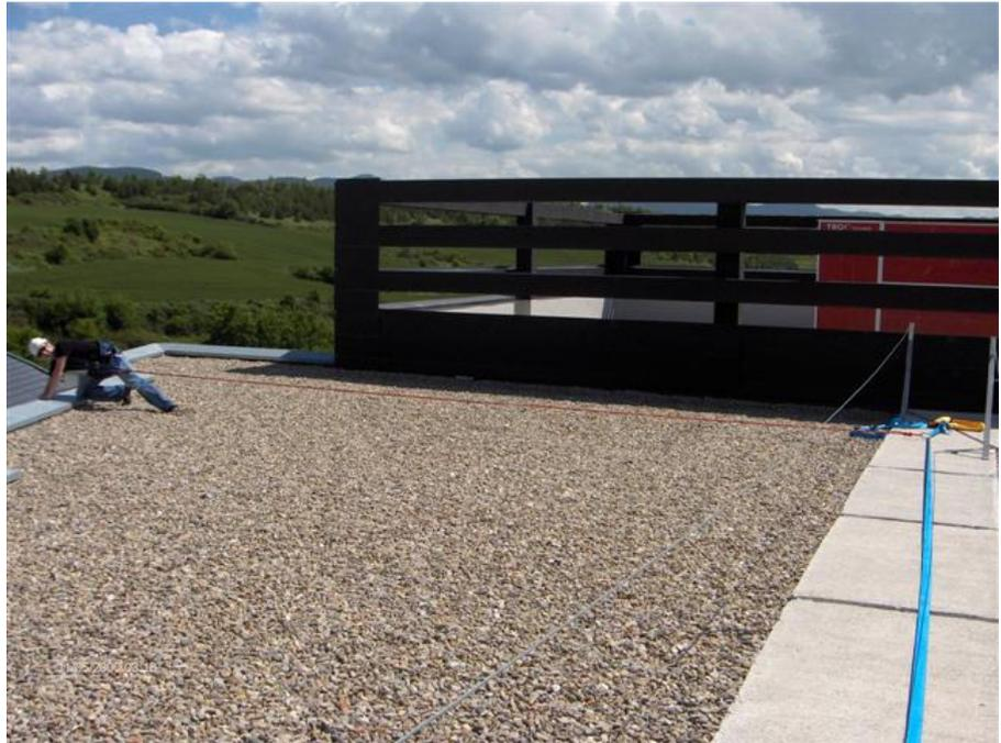
términos comerciales y de seguridad la instalación de una línea de vida portátil, es decir, un sistema de seguridad consistente en una cinta, cuerda o cable y un tensor.
